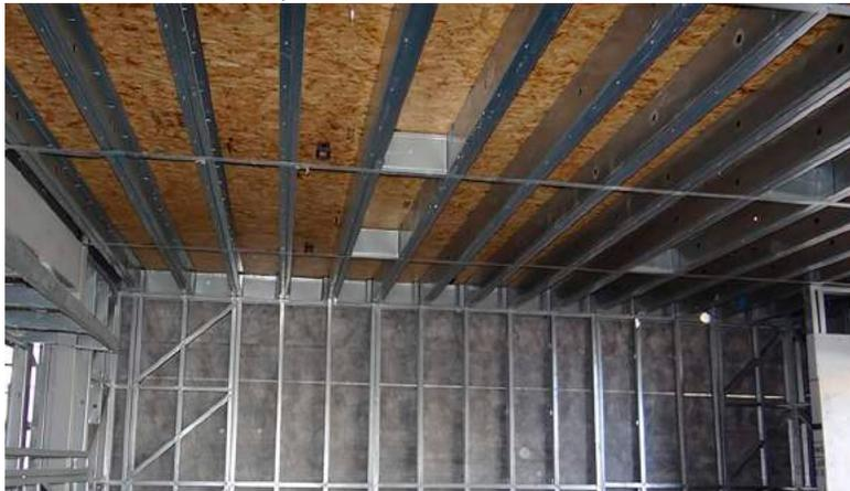
Foto 6.1 – Travamento horizontal da laje de piso por meio de bloqueadores e fitas de aço (Fonte: arquivo dos autores)
