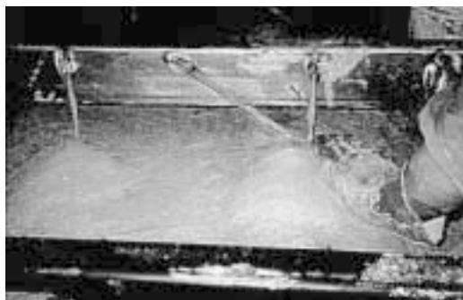
Foto 29 - Incorporação do enrijecimento metálico a painéis GRC (PCI, 1995).
