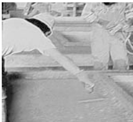
Foto 25 - Painel em adensamento manual (PCI, 1995).
