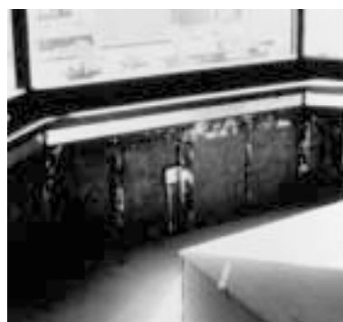
Foto 21 - Passagem de tubulações na cavidade entre os painéis de revestimento e o paramento interno (PCI, 1994).
