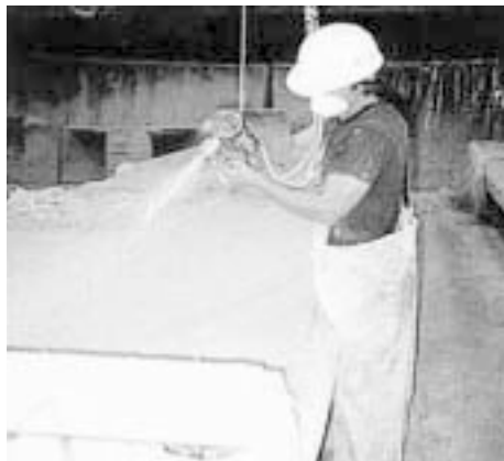
Foto 24 - Painel sendo produzido por projeção (PCI, 1995).
