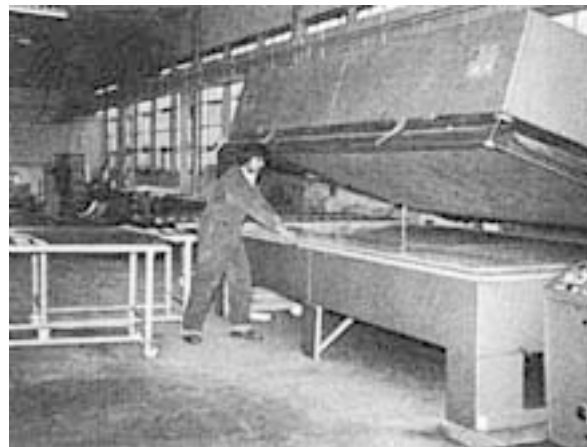
Foto 44 - Produção de painéis utilizando processo de pressão a vácuo (BROOKES, 1998).
