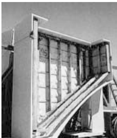
Foto 35 - Painel em GRC com enrijecimento metálico leve (PCI, 1994).
