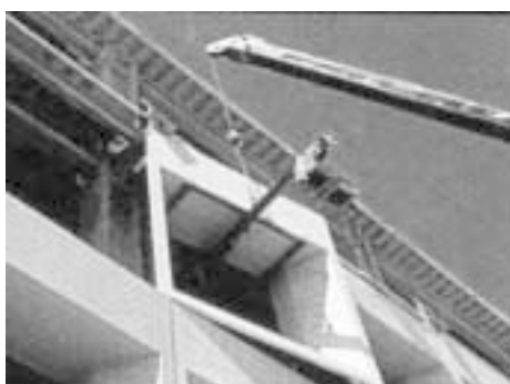
Foto 33 - Colocação de painel com esquadria recuada em relação ao plano da fachada (PCI, 1995).
