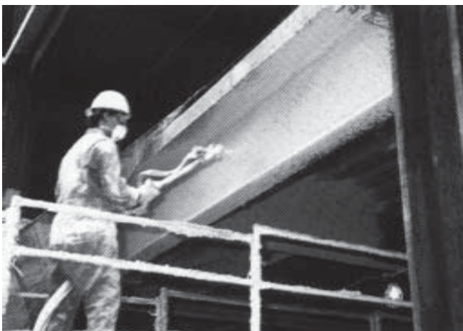
Figura 5.1 Aplicação de argamassa projetada "cimentitious" - Fonte: Grace do Brasil
