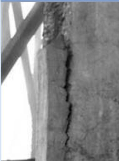
Figura 41 - Carbonização de pilar de madeira.
